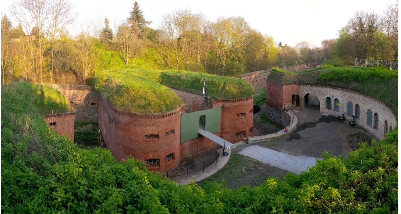
Fotos: Sanierungsverein Ravelin 2
